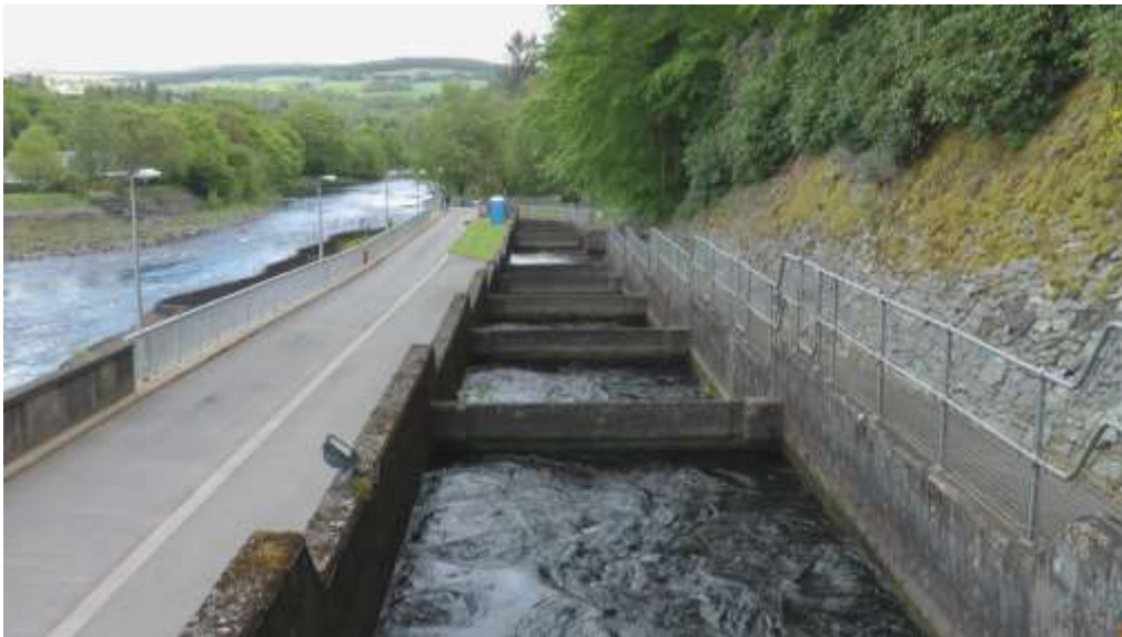
Die Fischleiter am Pitlochry Dam
